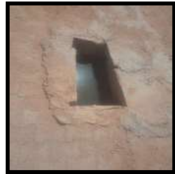
الصورة رقم(19): السواقي لتصريف المياه
