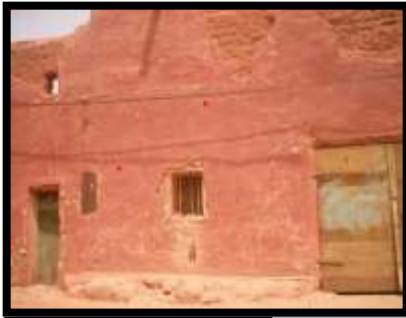
الصورة رقم (07): واجهة معمارية قديمة
