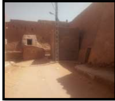
الصورة رقم(14): مدخل قصبة المنجور
